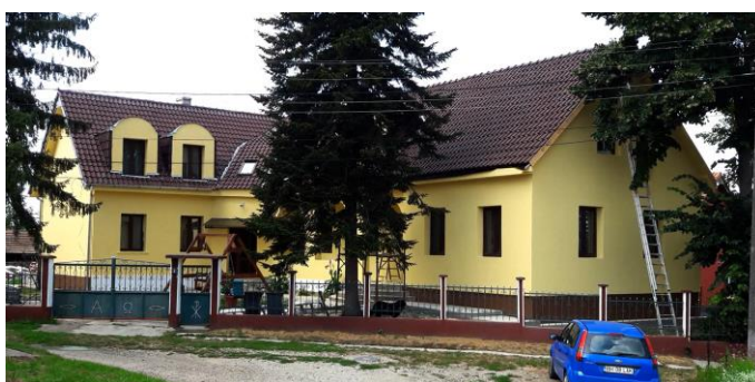
Foto: Paleu renovatie pastorie.
