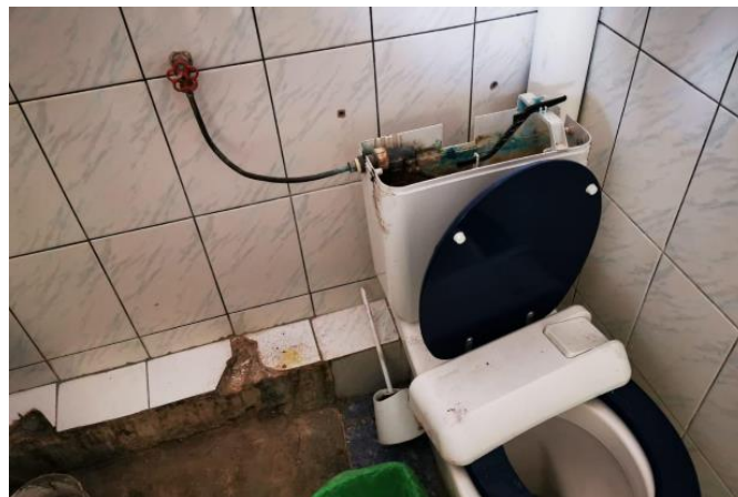
Foto: Oradea; Het vervangen van het waterleidingsysteem in het Julia Home.
